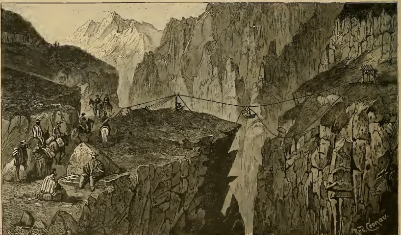
i. Reisezug und Seilbrücke in den Anden.
